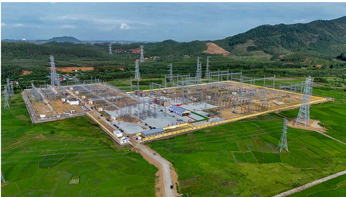
Trạm biến áp 500kV Vĩnh Yên (xã Bình Tuyền, tỉnh Phú Thọ) là một trong 3 điểm cầu trực tiếp của EVN
