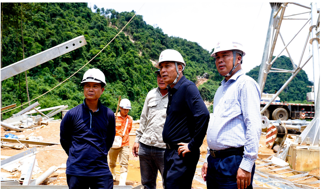
Ông Đặng Hoàng An - Chủ tịch Hội đồng thành viên EVN (thứ hai, từ phải sang) kiểm tra tiến độ thi công dự án đường dây Lào Cai - Vĩnh Yên, ngày 13/8/2025, tại tỉnh Lào Cai.
